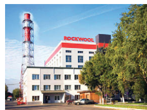
Завод Rockwool, Железнодорожный
