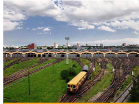
Депо станции метро Автово, Санкт-Петербург
