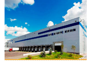
Складской комплекс Лешково, Московская обл.
