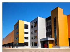
Складской комплекс PNK Group, Московская обл
