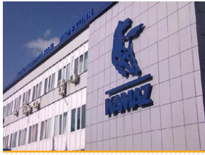
Инжиниринговый центр КАМАЗ, Набережные Челны
