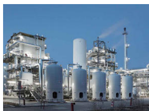
Завод Линде Газ Рус, Калужская обл.
