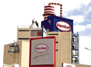
Завод строительных смесей Henkel, Ставропольский край
